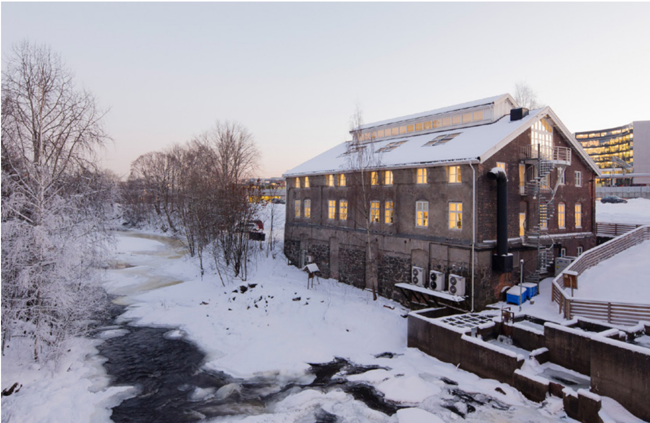
Link Arkitektur office, Umeå, Sweden
